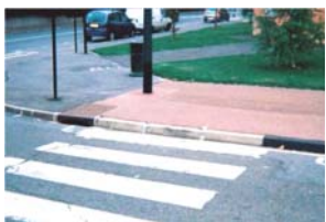
Exemple de bordure de trottoir non-abaissee au niveau d'un passage piéton
