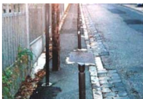
Exemple de trottoir de largeur inférieure à 1.40m et comportant des obstacles empêchant le déplacement d'une personne en fauteuil roulant
